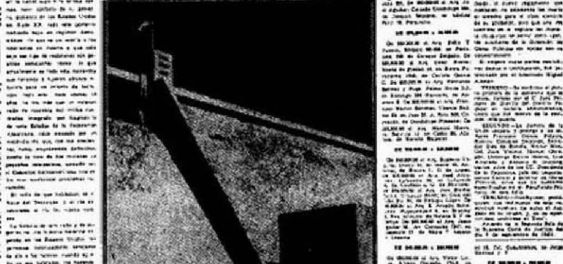
Una espectacular estructura de concreto que se levanta en el valle del río Tennessee...
